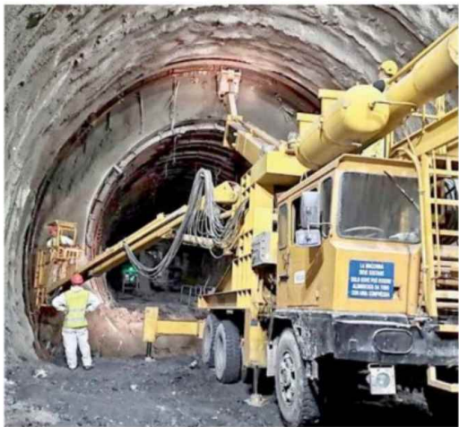
Il cantiere del Terzo valico a Radimero
