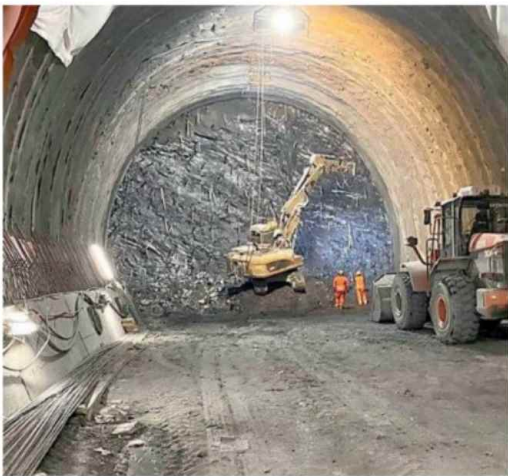
I lavori nel cantiere alessandrino di Voltaggio
