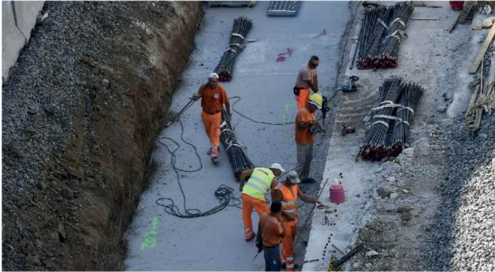
— Un cantiere Rfi (Imagoeconomica, Sara Minelli)
