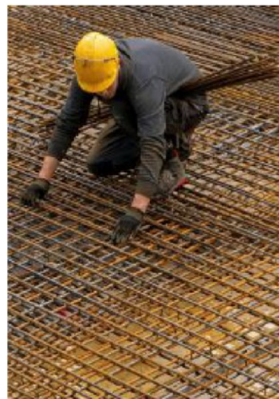
Cantiere Operaio al lavoro
