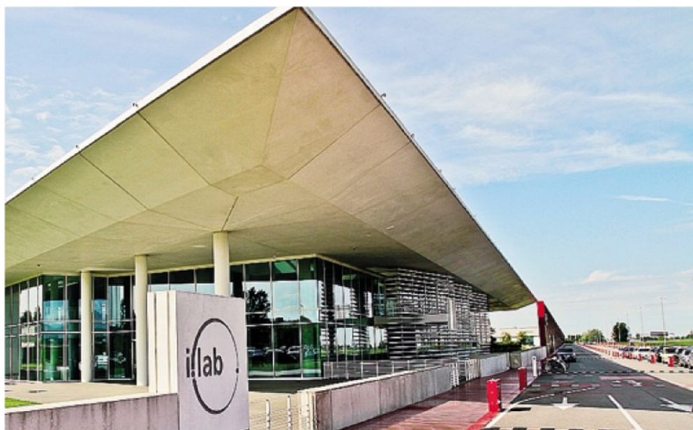
La sede dell'Italcementi e del Centro innovazione di prodotto i.lab al Kilometro Rosso
