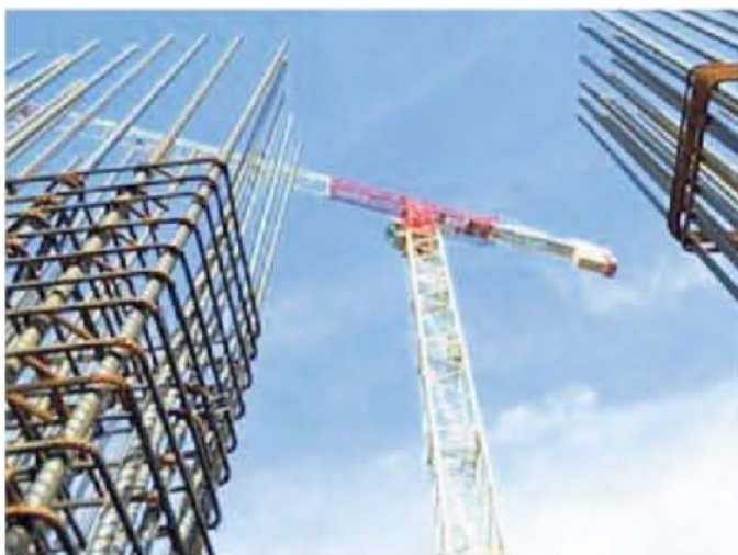
Un cantiere edile
