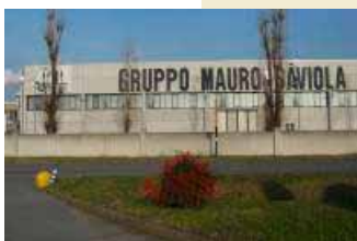
Lo stabilimento a Viadana
