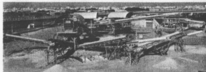
■ L'impianto denominato Rose (Recupero omogeneizzato scarti edilizia)
