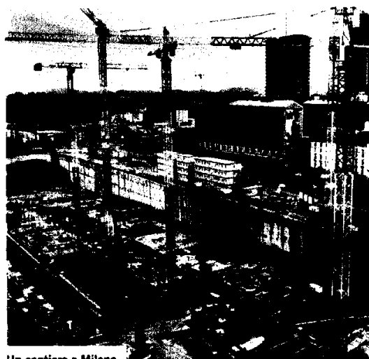
Un cantiere a Milano
