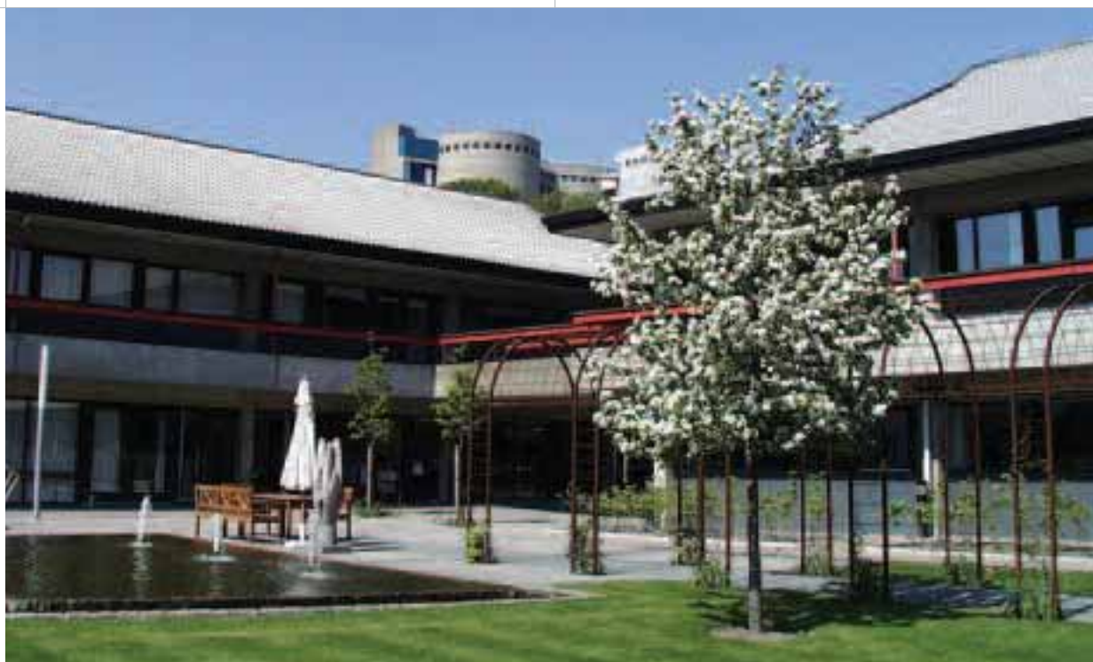
La sede di Aalborg Portland - Danimarca
